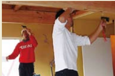
アンティーク感を出すために、手斧で梁をカットしています。
