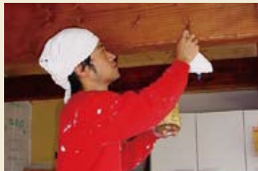
その後、自然素材の塗料で色を付けています。
