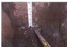
基礎コンクリート確認 フーチング無し
